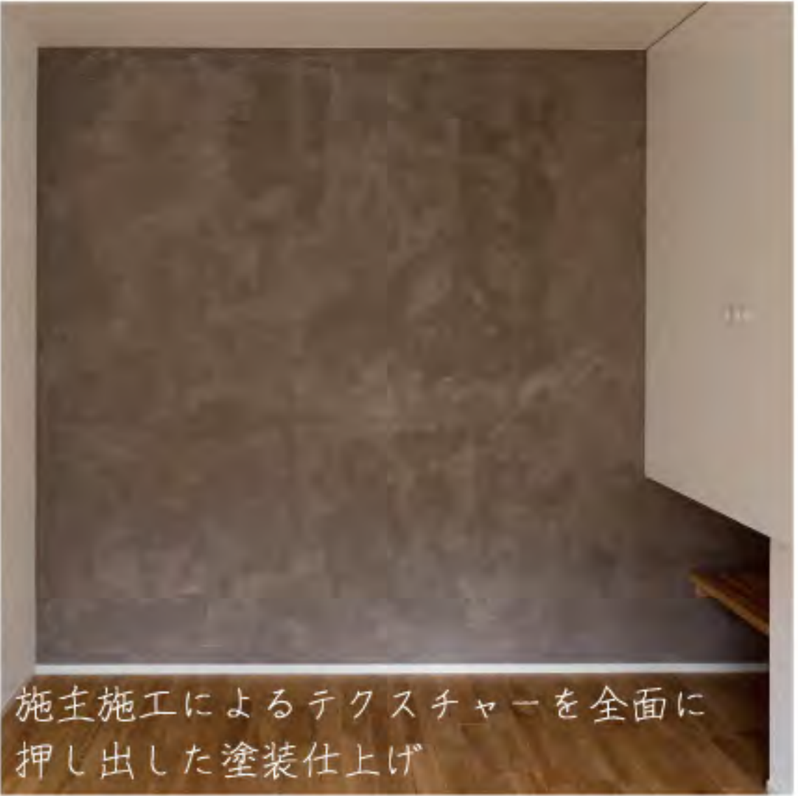
モルタルの白華を意図的に出した職人技 が光る左官仕上げを漆喰のアクセントに
